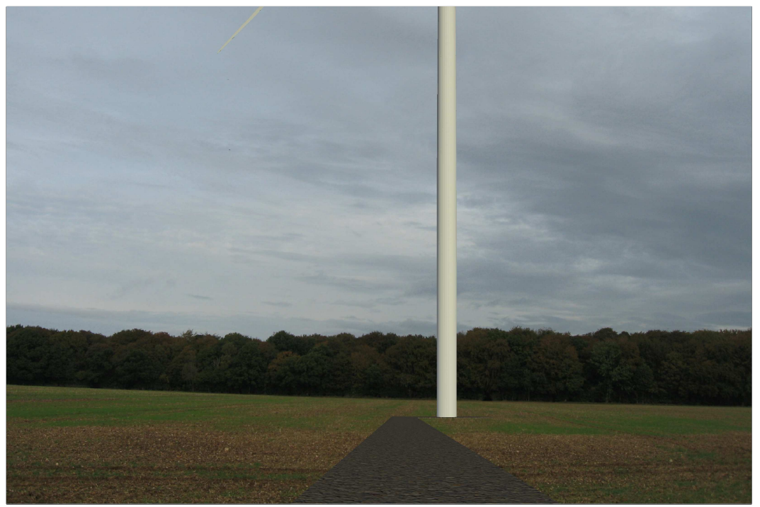
Eolienne n° 6 : Vue après implantation
